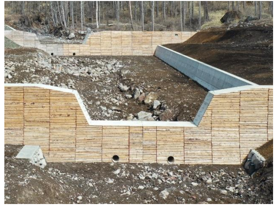
丸太残存型枠（長野県富士見町） [国有林治山工事]
